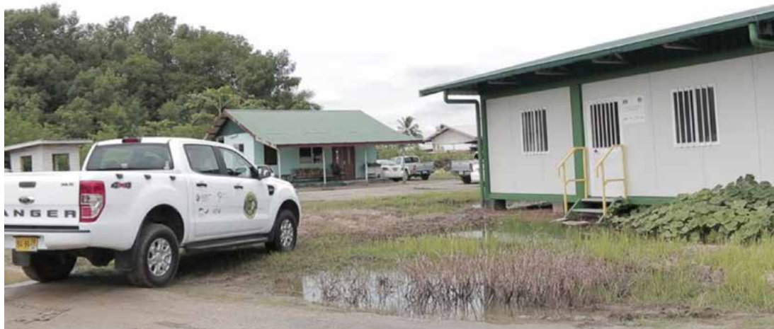
Nuevo edificio construido con recursos canalizados por el Proyecto Bioamazonía de la OTCA y KfW
